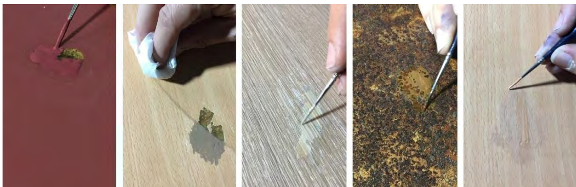
Fig. 4.1.3.3 Vopsirea zonei reparate
