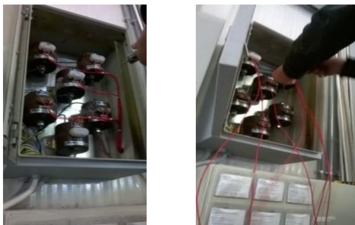
Fig. 78. Realizarea tabloului electric și instalarea transformatoarelor de curent [134]
